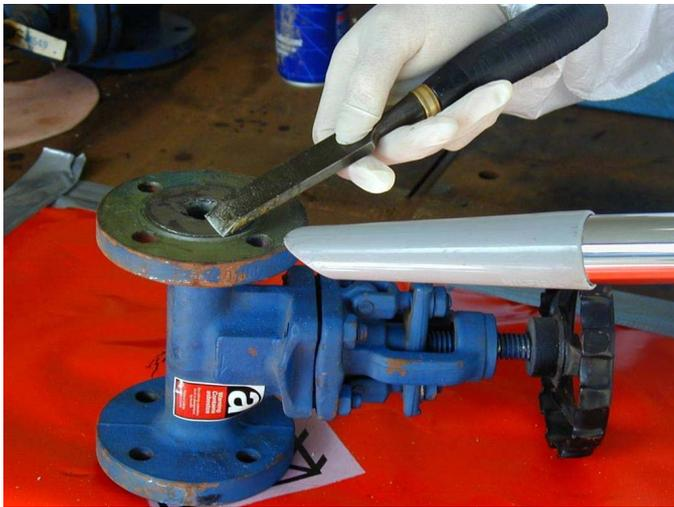
**Figura 11.6** Utilizzazione di aspiratori per catturare le polveri generate nel rimuovere l'amianto da una valvola.
