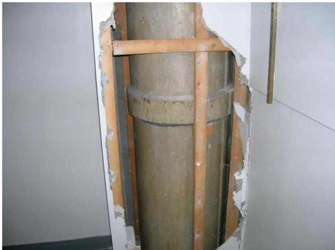
**Figura 4.2** Elemento di rivestimento isolante in amianto parzialmente rimosso per mostrare dietro di esso la conduttura in amianto cemento.
