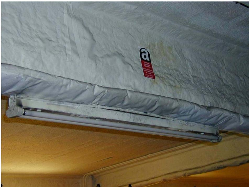
**Figura 4.11** Isolamento in amianto su acciaio strutturale.
