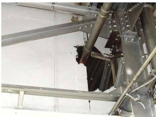
**Figura 4.3** Tramezzo isolante in amianto. Questo esempio illustra le difficoltà pratiche che si incontrano nel costruire un'adeguata struttura di confinamento e mostra inoltre le superfici sulle quali può raccogliersi la polvere di amianto durante il procedimento di rimozione.
