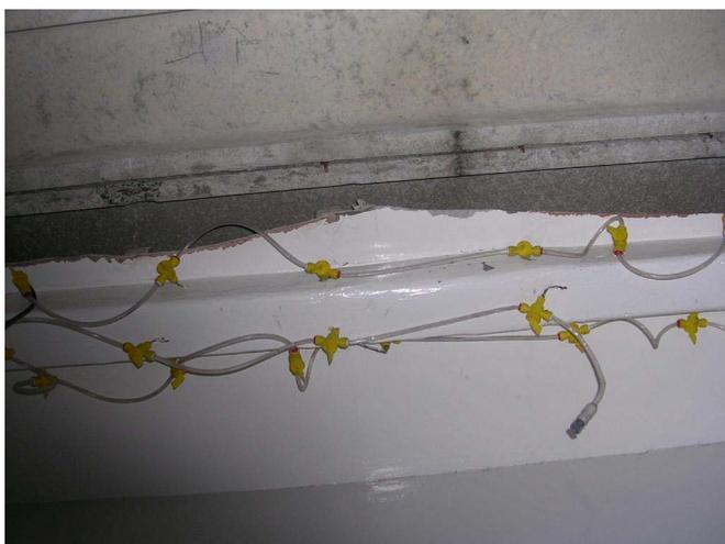
**Figura 12.10** Esempio di iniezione multipla utilizzata per umidificare uno strato di isolamento spruzzato di amianto.
