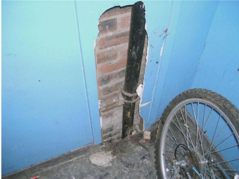
**Figura 6.4** Pannello isolante in amianto; la rimozione deve essere effettuata con particolare attenzione dal momento che il pannello in quel punto è suscettibile di subire danneggiamenti.
