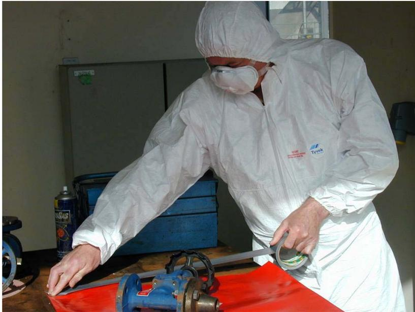
**Figura 11.3** Utilizzazione di un nastro e di fogli in polietilene per proteggere un'area di lavoro prima di pulire i giunti in amianto di una valvola.
