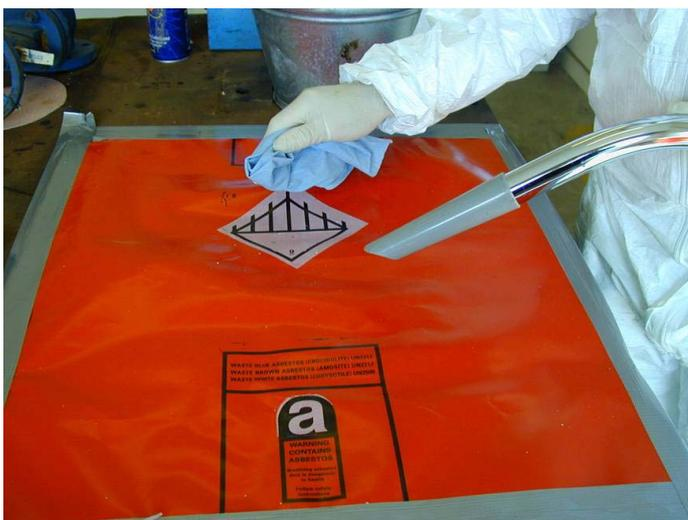
**Figura 11.7** Pulitura completa dell'area di lavoro con un aspiratore di tipo H e panni umidi.
