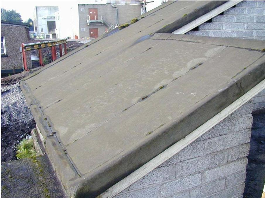
**Figura 4.7** Feltro per tetto in amianto.
