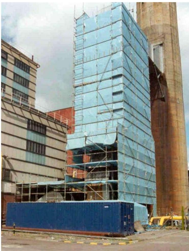
**Figura 12.3** Struttura di confinamento per la rimozione dello strato isolante da un condotto per gas.
