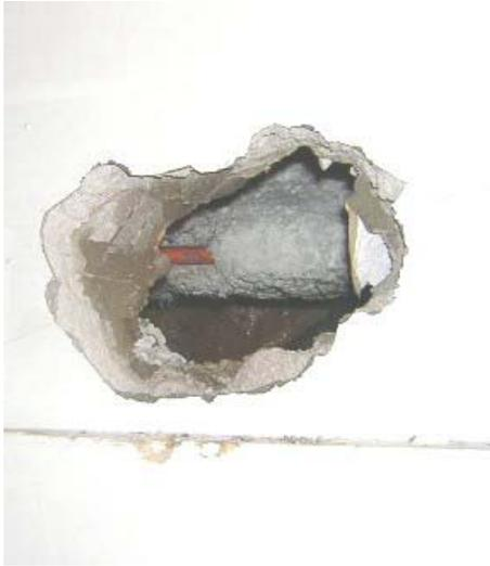
**Figura 4.4.** Penetrazione all'interno di un muro per mostrare l'isolamento della conduttura in amianto.
