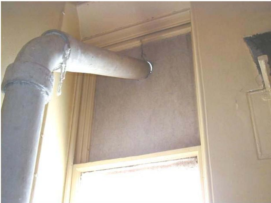
**Figura 4.5** Condotta in amianto cemento con rivestimento a tenuta in amianto che passa attraverso un pannello interno in amianto.
