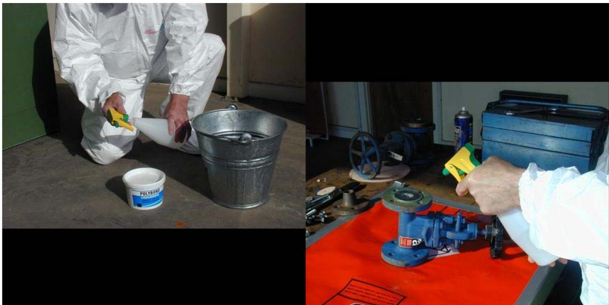
**Figura 11.4** Bagnatura dei giunti d'amianto di una valvola.
