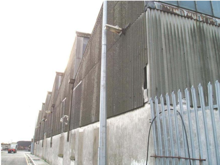
**Figura 4.10** Rivestimento in amianto cemento su una fabbrica.
