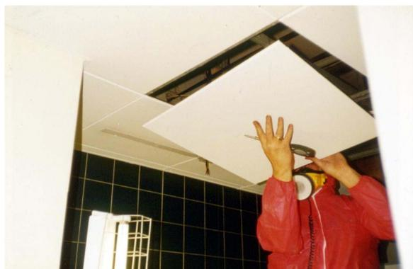
**Figura 12.13** Rimozione con ogni precauzione di una piastrella in amianto. Immagine fornita dallo HSE del Regno Unito.
