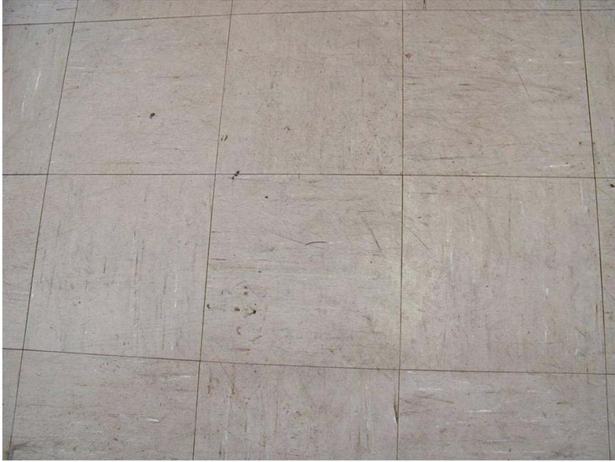
**Figura 4.6** Piastrelle per pavimento in amianto.
