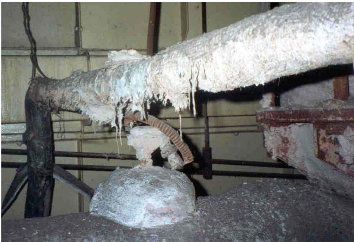
**Figura 4.8** Isolamento in amianto su tubature per vapore.
