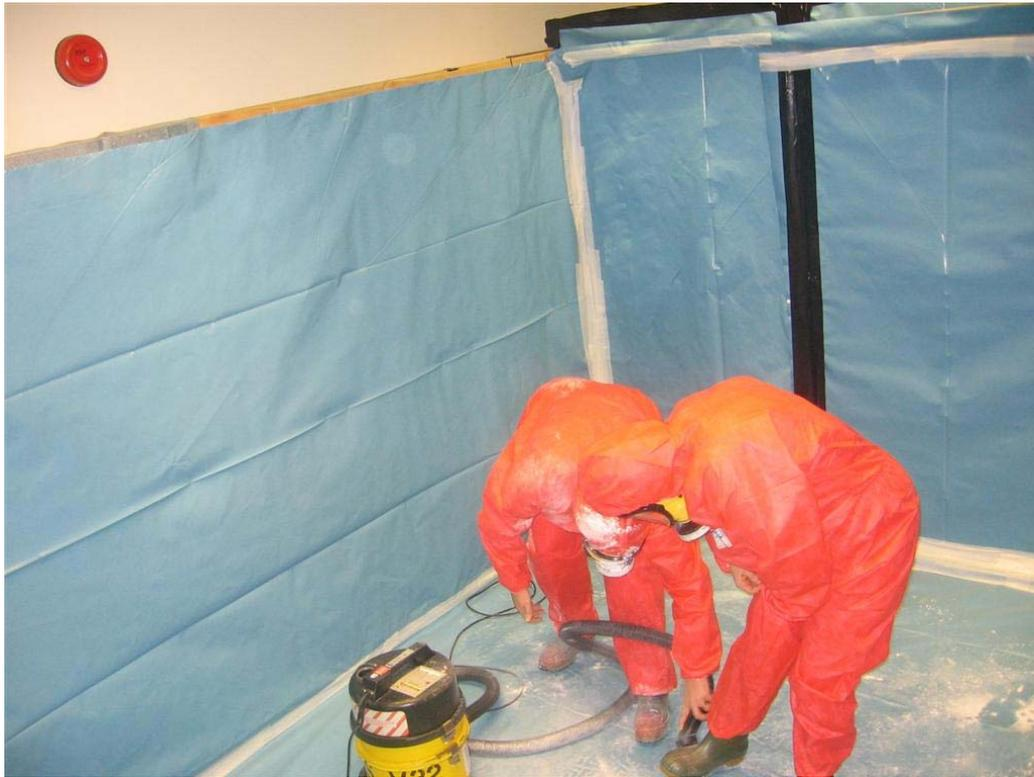
**Figura 7.1** Addestramento pratico all'utilizzazione degli aspiratori tipo H per rimuovere sostanze contaminanti simulate (polvere di talco). Immagine fornita dallo HSE del Regno Unito.
