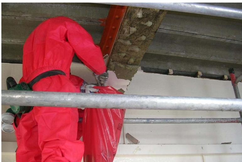
**Figura 12.11** Insaccamento dei rifiuti vicino al punto di rimozione al fine di prevenire la diffusione e minimizzare l'esposizione.
