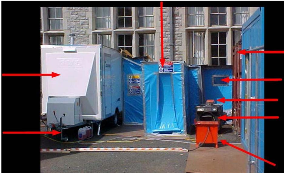
**Figura 12.1** Entrata di una struttura di confinamento; le frecce, dall'alto in senso orario, indicano: l'accesso a tenuta per l'evacuazione dei rifiuti, il contenitore dei rifiuti, l'oblò, il misuratore della pressione negativa, il gruppo a pressione negativa, l'alimentazione elettrica, il serbatoio dell'agente umidificante e l'unità di decontaminazione.
