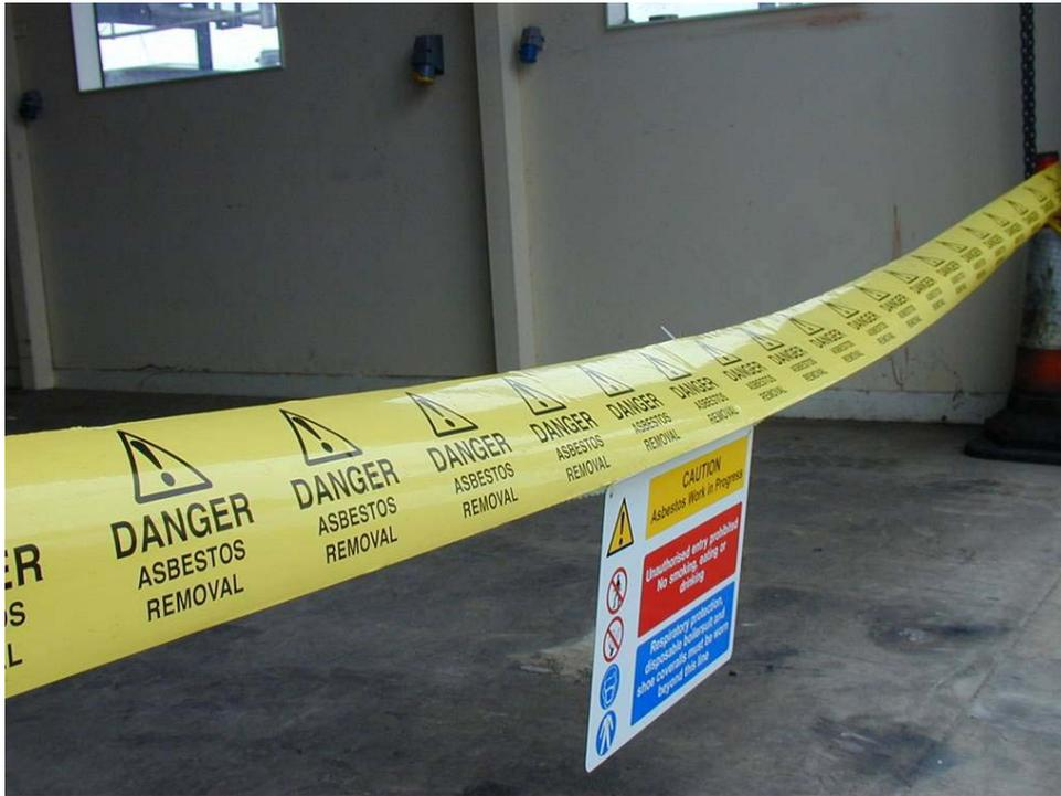
**Figura 11.1** Utilizzazione del nastro di avvertimento (con la dicitura “Pericolo rimozione amianto”) e di segnali per delimitare un’area.
