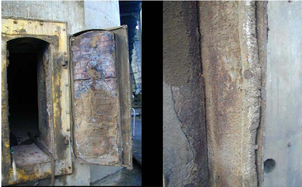
**Figura 4.12** Rivestimenti in amianto a tenuta per porta di camino. L'immagine a sinistra è un'immagine ravvicinata del rivestimento in amianto.
