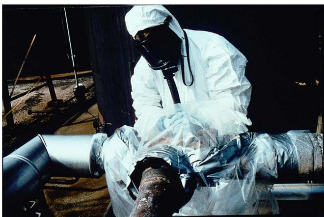
**Figura 12.12** Sacche con guanti utilizzate per la rimozione controllata dell'isolamento in amianto (fotografie fornite da INRS; copyright INRS).
