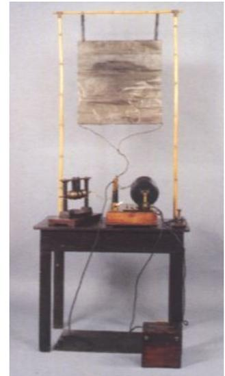
Riproduzione dell'apparato trasmettente dei primi esperimenti di Marconi. Si noti, in alto, l'antenna a pannello e in basso, a sinistra, l'oscillatore e, a destra, il rocchetto di Ruhmkorff (Fondazione Guglielmo Marconi, Collezione Bigazzi)
