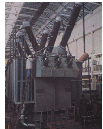
Trasformatore da 315 MVA, 420 kV/18 kV (Comelmar Italia)
