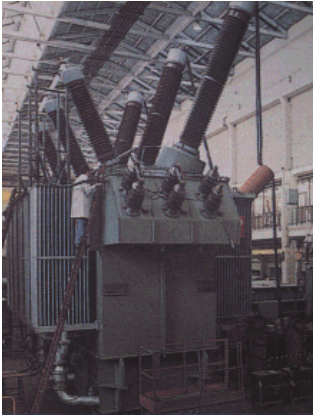
Trasformatore da 315 MVA, 420 kV/18 kV (Comelmar Italia)
