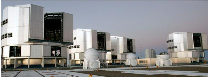
Figura 2.20: Il sito del Very Large Telescope. I quattro grandi capannoni che si distinguono sono gli alloggiamenti dei 4 telescopi da 8 metri che compongono il VLT. Si distinguono anche alloggiamenti più piccoli: questi contengono telescopi di diametro minore ma che possono muoversi sui binari visibili a terra per ottenere migliori condizioni per le osservazioni interferometriche (<http://www.hq.eso.org/paranal/>).
