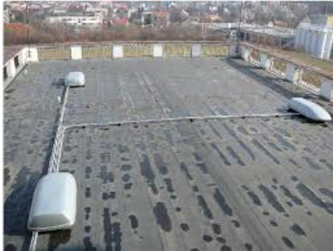
Figura 1.6: Una delle stazioni ALTA in Canada; gli involucri bianchi contengono gli scintillatori.
